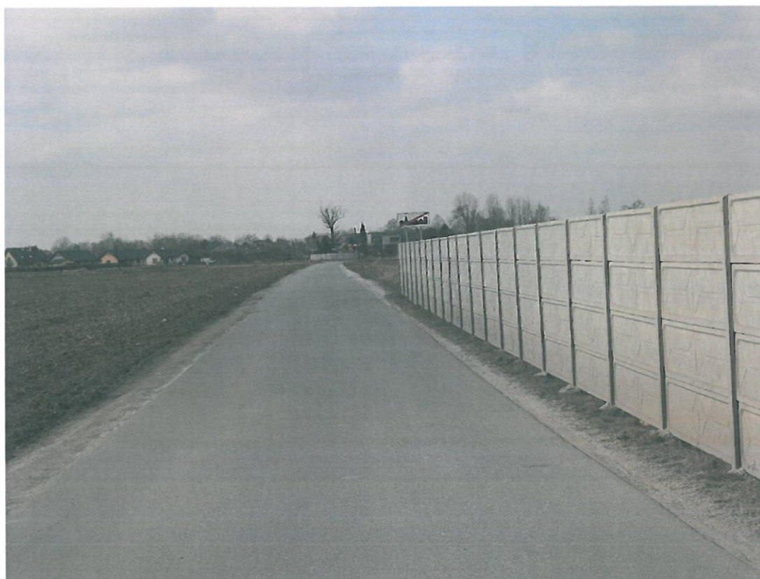
Fot. 8. Oznakowanie przejazdu z kierunku jazdy samochodu (brak znaków A10, G1a, G1b, G1c)
