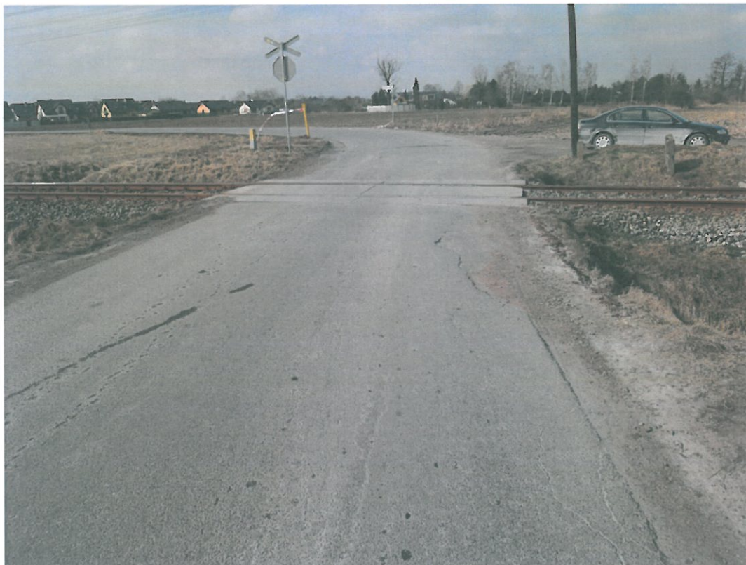
Fot. 7. Widok przejazdu z kierunku zbliżającego się samochodu
