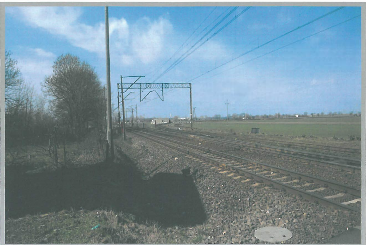
Widok z odległości 5 metrów od skrajnej szyny z wysokości 1,20 metra od nawierzchni drogi (czoło pociągu jest widoczne, gdy znajduje się ok. 400 m. od osi przejazdu).
