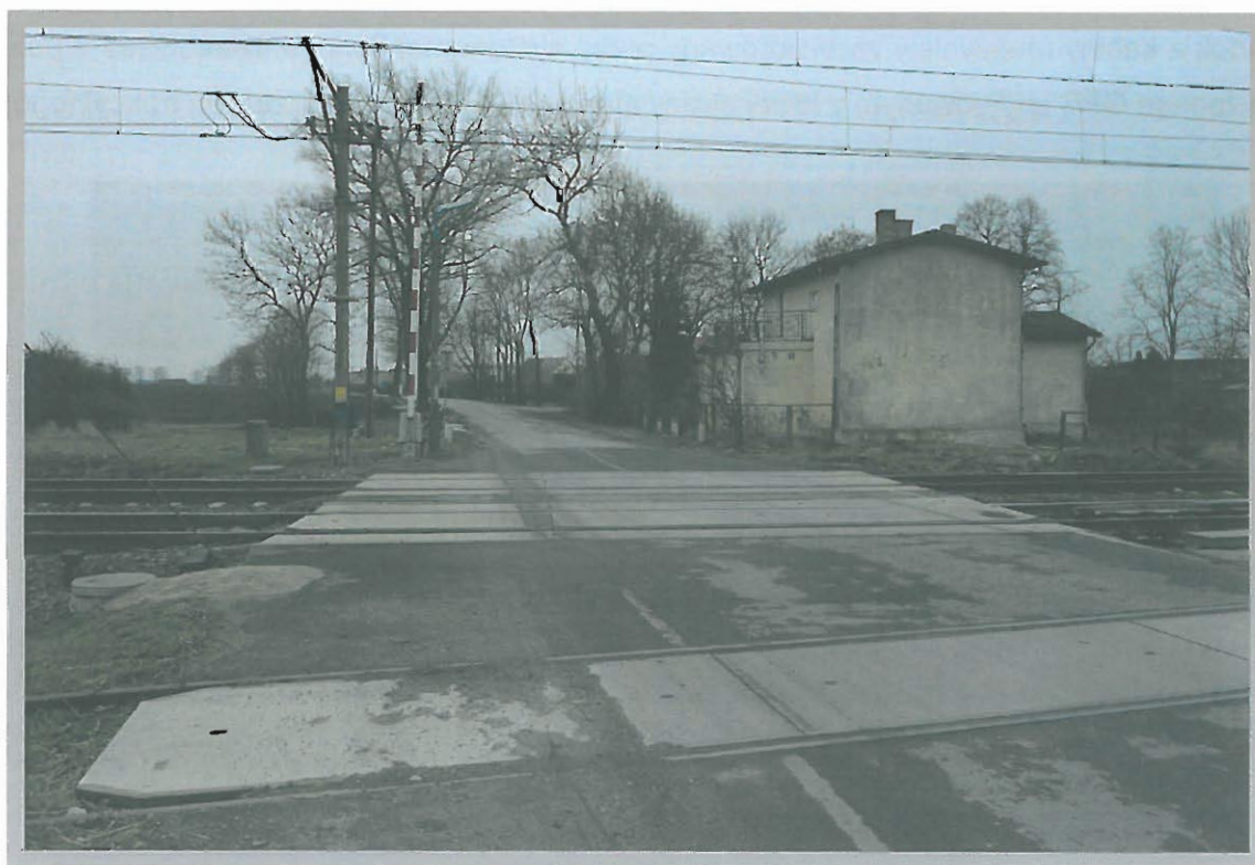
Ukształtowanie drogi dojazdowej do przejazdu z prawej strony w kierunku jazdy pociągu.
