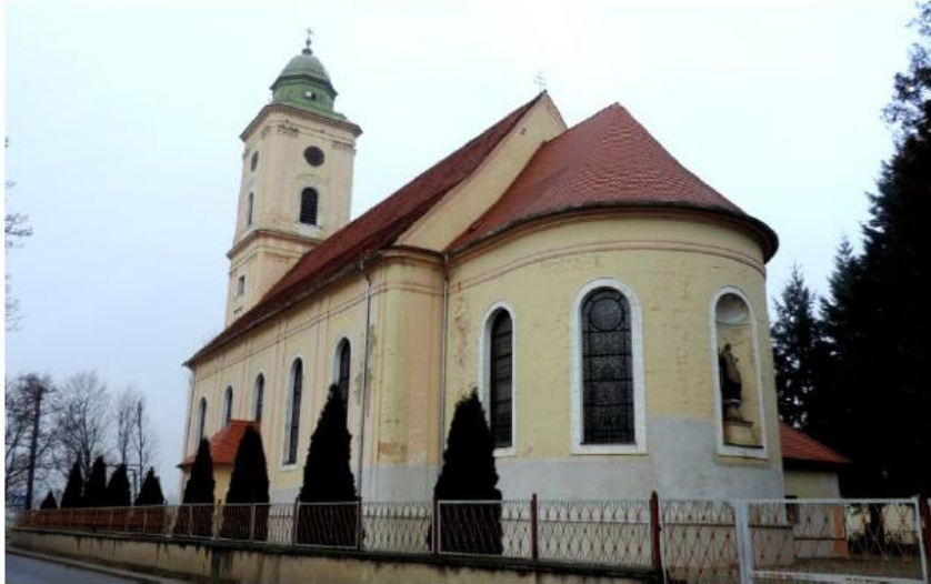
Zdjęcie nr 3. Kościół rzymsko - katolicki parafialny pw. Wniebowzięcia NMP, ul. Wrocławska 49, Bukowice
