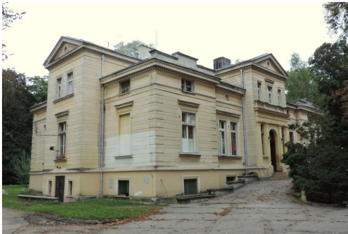
Zdjęcie nr 17. Pałacyk, ob. Dom Opieki im. A. Chmielewskiego, Szczodre, ul. Trzebnicka 28
