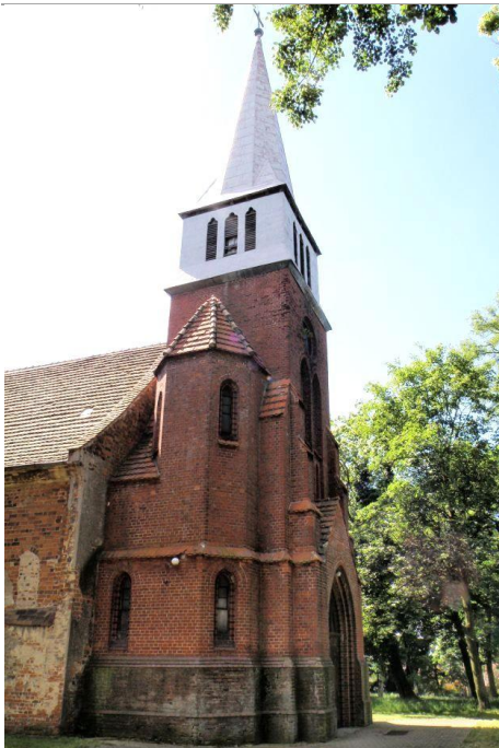
Zdjęcie nr 10. Kościół parafialny Wniebowzięcia NMP, Łozina, ul. Wrocławska 1
