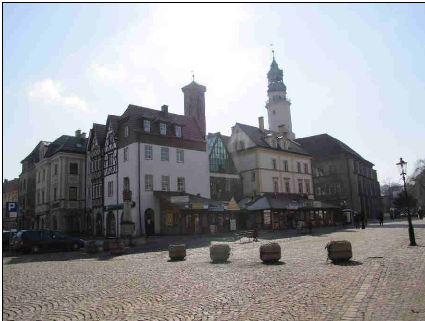
Fot. Odbudowany blok śródrynkowy - „Tret”. (Zdjęcie własne).
