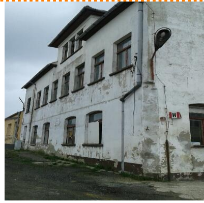
Budynek Olszyńskich Fabryki Mebli, ul. Wolności 20
