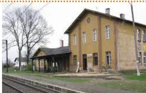
Budynek dworca PKP, ul. 1 Maja
