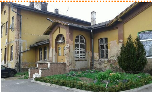
Budynek dworca PKP, ul. 1 Maja
