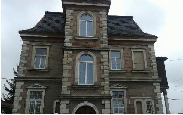
Budynek Urzędu Miejskiego, ul. Wolności 6
