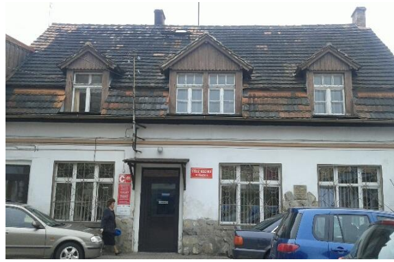
Budynek Urzędu Miejskiego, ul. Wolności 6
