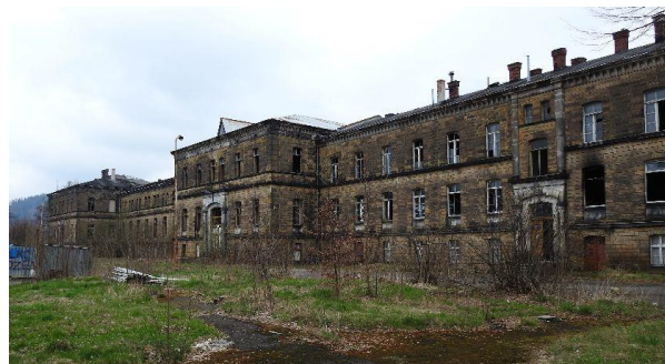
Fotografia 16. Widok na budynek dworca w Lubawce.
