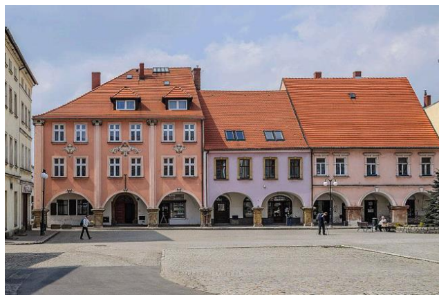
Fotografia 1. Widok na Plac Wolności 6–8, Lubawka - widok od wschodu [3].
