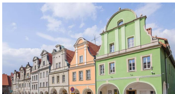
Fotografia 2. Chełmsko Śląskie, Rynek, pierzeja północno-wschodnia, widok od południowego wschodu [3].
