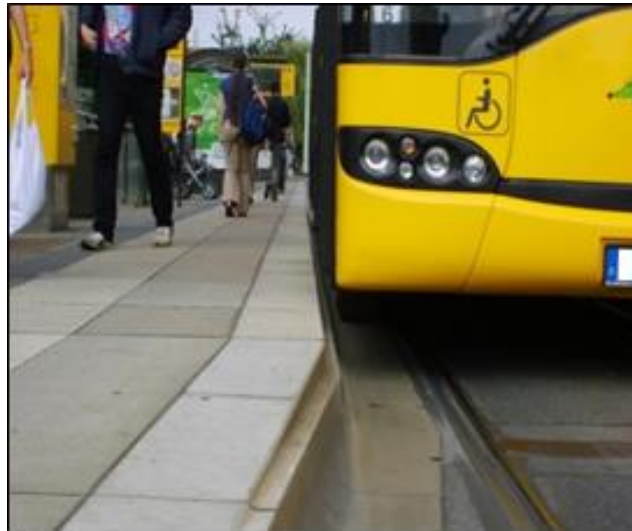
Rys. 8.6.1. Zalecane ukształtowanie krawędzi peronowej.
