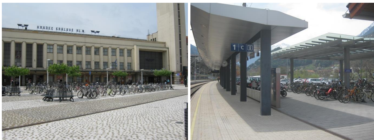
Rys. 12.3.2. Zdjęcie po lewej przedstawia stojaki rowerowe w systemie „bike and ride” przed dworcem kolejowym Hradec Králové hlavní nádraží w Czechach; na zdjęciu po prawej zaprezentowano stojaki rowerowe zamontowane bezpośrednio przy peronie kolejowym na dworcu w Landeck w Austrii. Dodatkowym atutem jest zadaszenie stojaków na całej długości.
