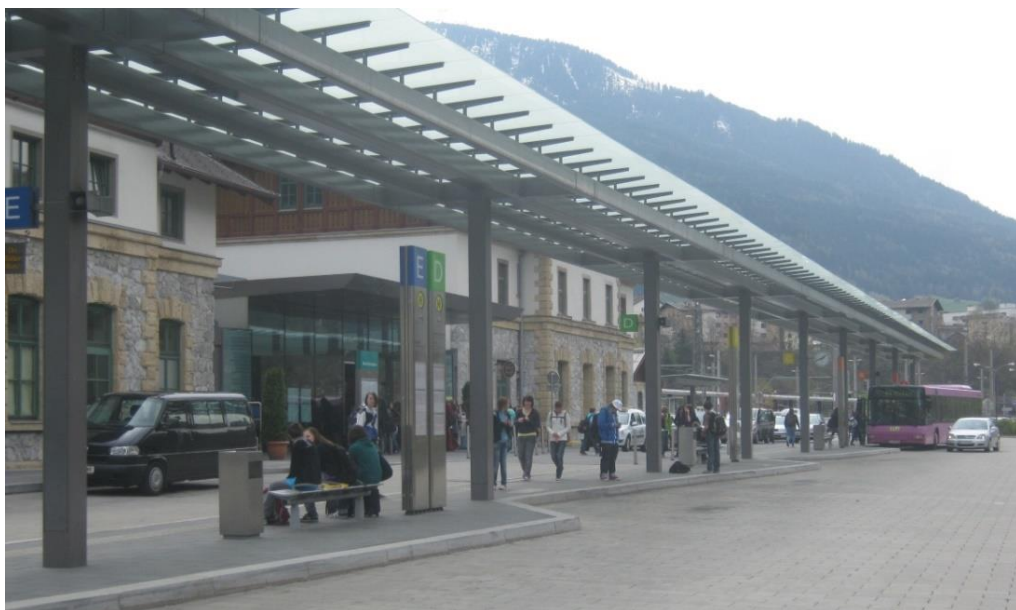
Rys. 12.3.1. Perony autobusowe przed dworcem kolejowym w miejscowości Landeck (Austria). Zaprojektowanie peronów w taki sposób ułatwia ich opuszczenie przez autobus.
