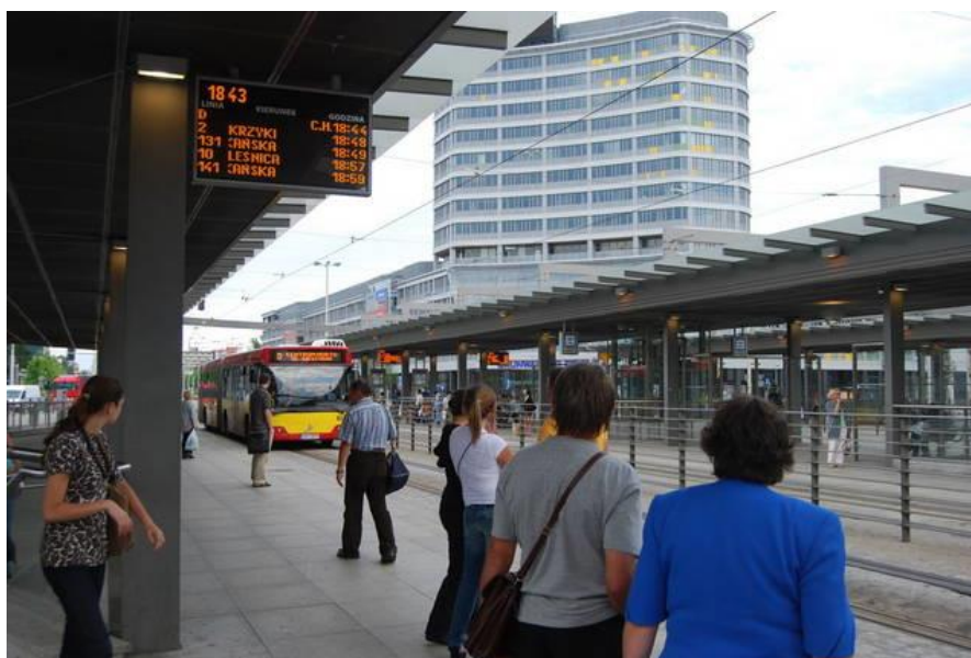
Rys. 11.1.2. Przykład węzłowego przystanku autobusowego ze z dynamiczną tablicą informacyjną (Wrocław, Plac Grunwaldzki).
