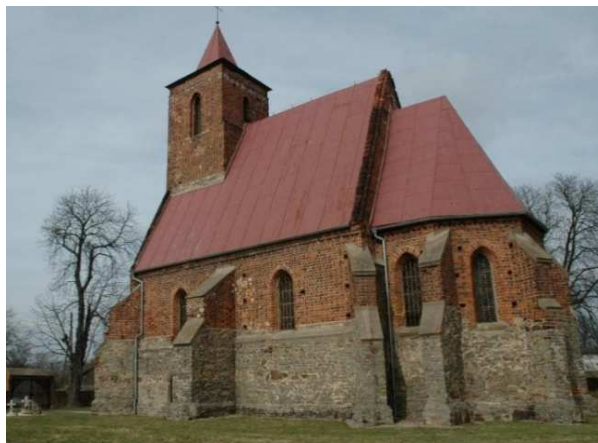
Fot. 12. Wilczków. Kościół pw. Wniebowzięcia NMP (źródło: https://zabytek.pl ).
