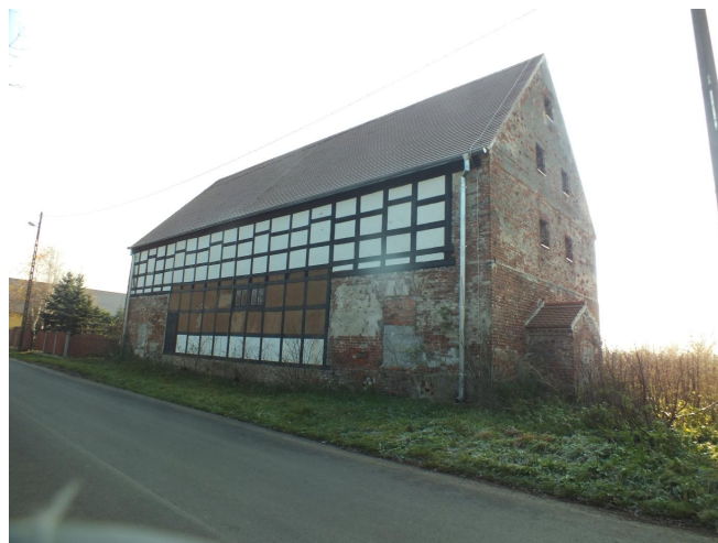
Fot. 16. Częściowo wyremontowany spichlerz w Drogłowicach
