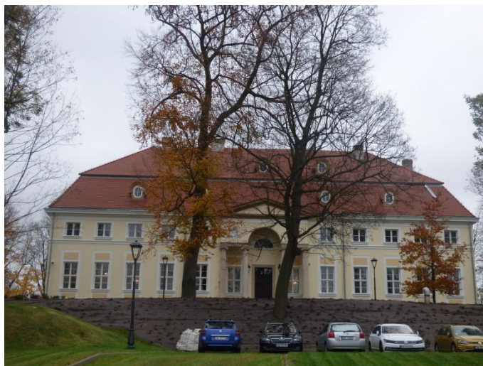
Fot. 23. Pałac w Żerkowie Źródło: fotografia własna
