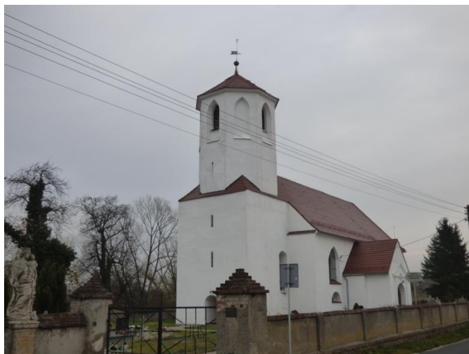
Fot. 13. Kościół p.w. Wszystkich Świętych w Brzegu Dolnym
