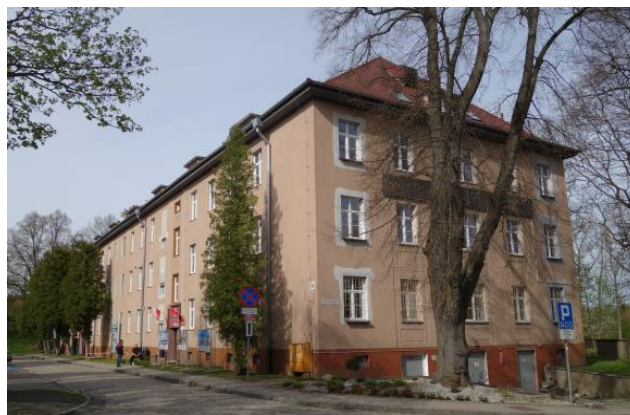
Fot.19. II budynek Starostwa Powiatowego
