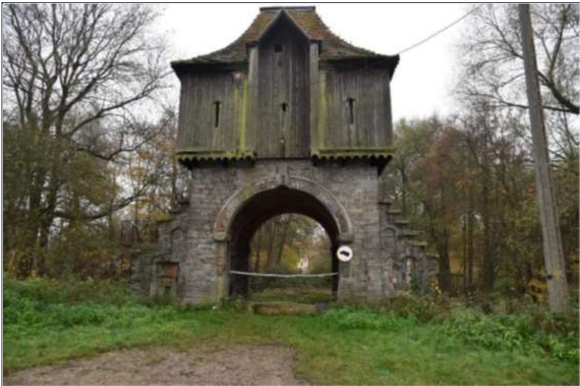
Rysunek 36. Budynek bramny w zespole pałacowo-folwarcznym w Krobielowicach
