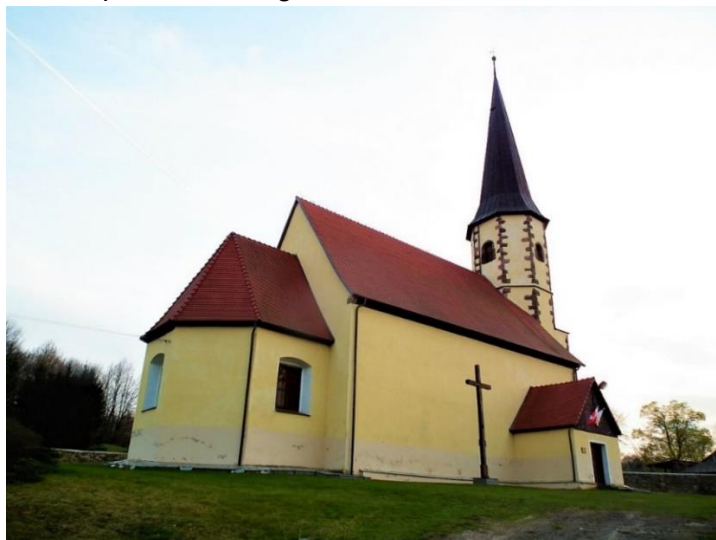
Fot. 7.3.6: Kościół pw. św. Jerzego w Kondratowie
