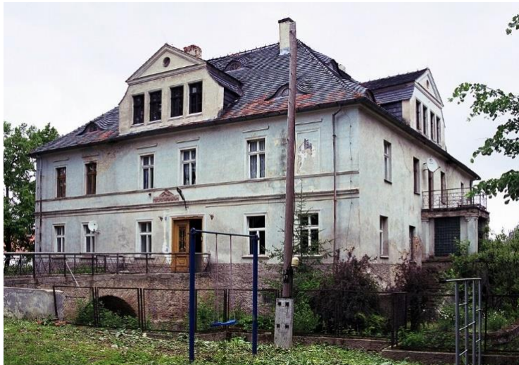
Fot. 7.5.7: Pałac w Wiadrowie
