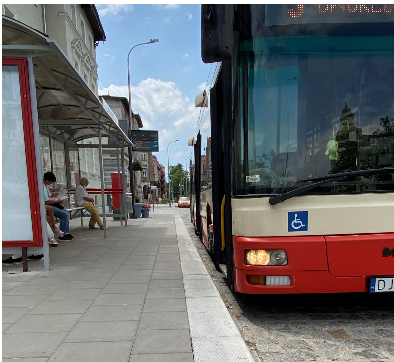
Rys. 9.3 Zalecane ukształtowanie podniesionej krawędzi peronowej
