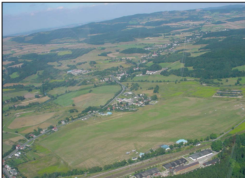
Rys. 4.10 Lotnisko w Jeleniej Górze
