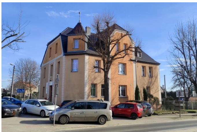
Zdjęcie nr 6. Dom mieszkalny, ob. przychodnia lekarska, ul. Reymonta 1 w Zgorzelcu
