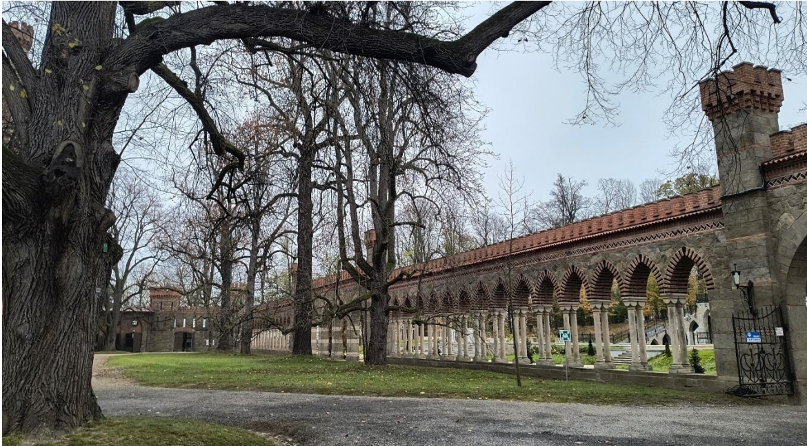
Fot. 37. Arkady przy pałacu Marianny Orańskiej w Kamieńcu Ząbkowickim inspirowane były sztuką włoską, w tym zabytkami Florencji. Neogotyckie, dwubarwne łuki ceglane chętnie wykorzystywał w swoich projektach F. Schinkel. Fot. M. Kaluch - Tabisz
