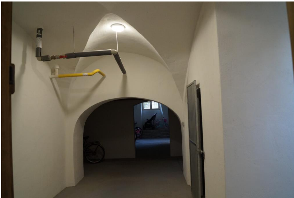
Nieszczyce, pałac, piwnice, stan wrzesień 2025 r.
