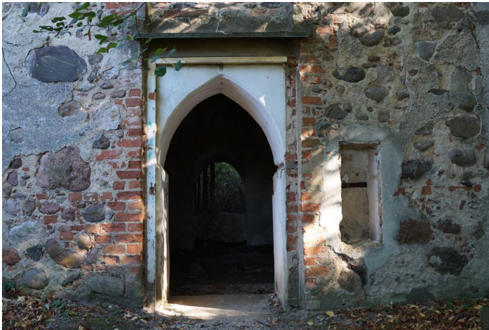
Górzyn, ruina kościoła - wejście, stan wrzesień 2025 r.
