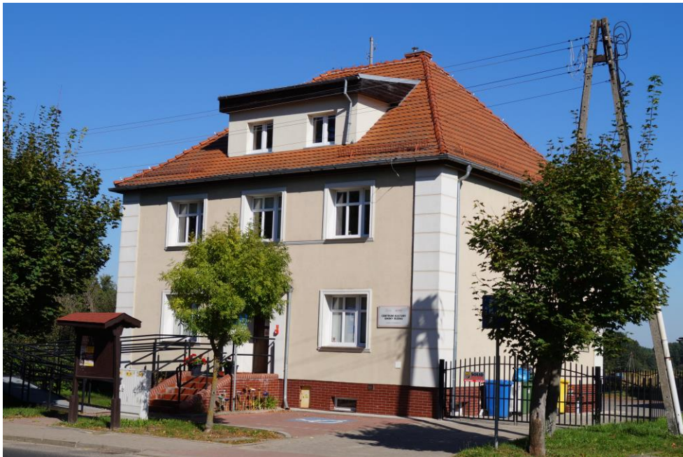
Rudna, budynek mieszkalny, obecnie Centrum Kultury Gminy Rudna, ul. Ścinawska 19, stan wrzesień 2025 r.
