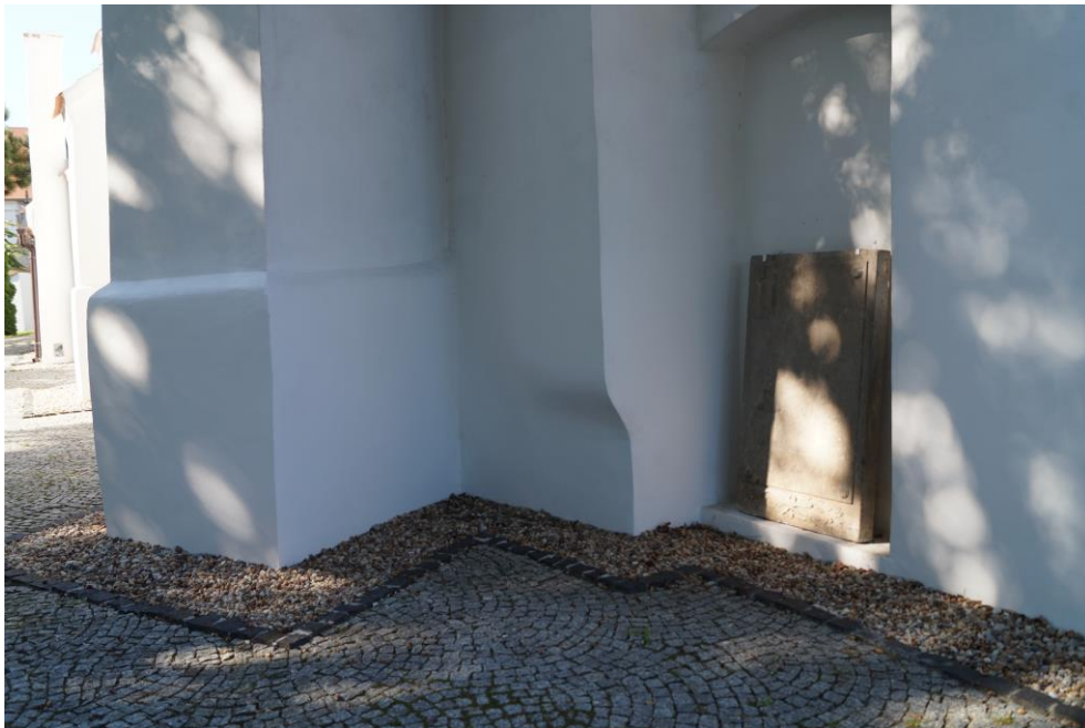
Chobienia, kościół parafialny pw. Piotra i Pawła, wyremontowany cokół budowli, stan wrzesień 2025 r.
