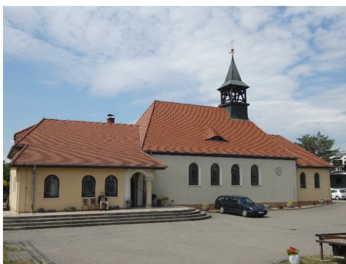
Fot. 16. Kościół w Radwanicach
