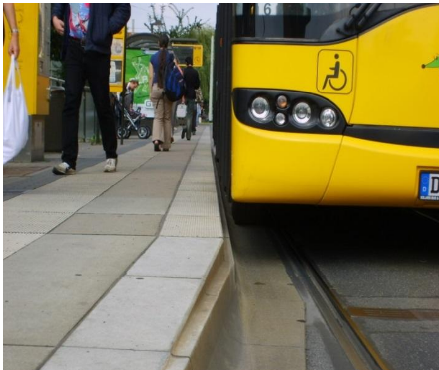
Rys. 8.2 Wyrównanie wysokości krawędzi peronowej z pierwszymi drzwiami autobusu Źródło: Materiały własne
