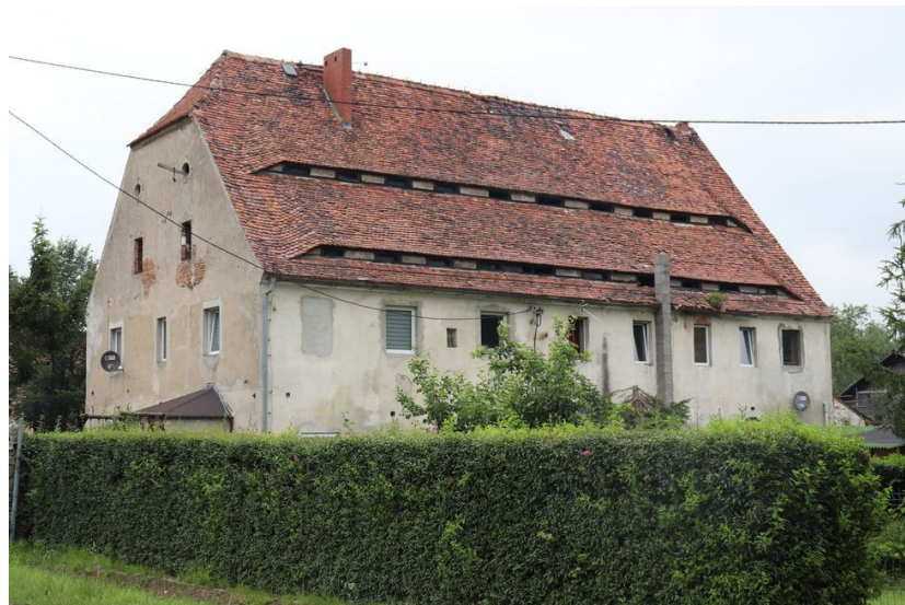
Ryc. 26: Budynek mieszkalny zarządcy majątku w Tylicach.
