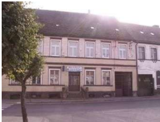
Dom przy ul. Rynek 1 w Bledzewie (nr rejestru 784 z 15.02.1964r.)
