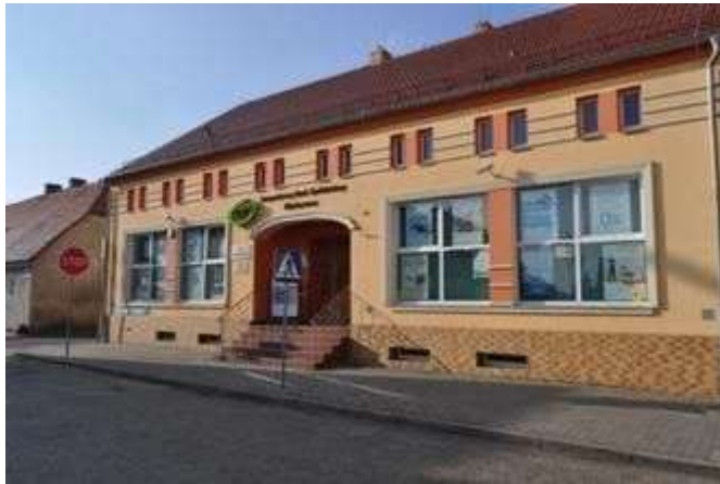
Dom przy ul. Rynek 4 w Bledzewie (nr rejestru 848 z 15.02.1964r.)
