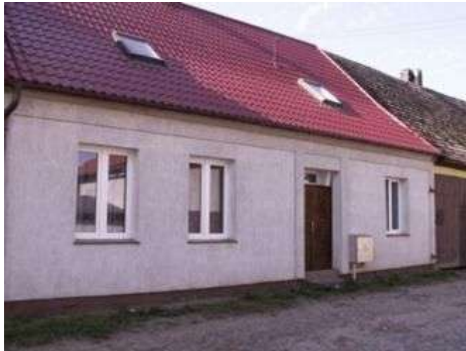
Dom przy ul. Rycerskiej 6 w Bledzewie (nr rejestru 858 z 15.02.1964r.)
