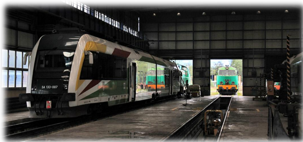
Fot. 3 – Wnętrze hali utrzymania taboru w Rzepinie
