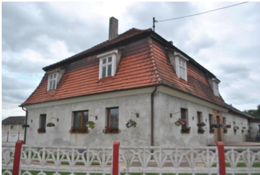
Ryc. 22. Budynek folwarczny w Chełmku. Fot. Edyta A. Marek
