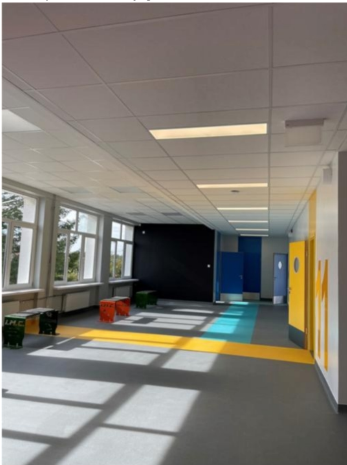
SP Baczyna -modernizacja pomieszczeń
