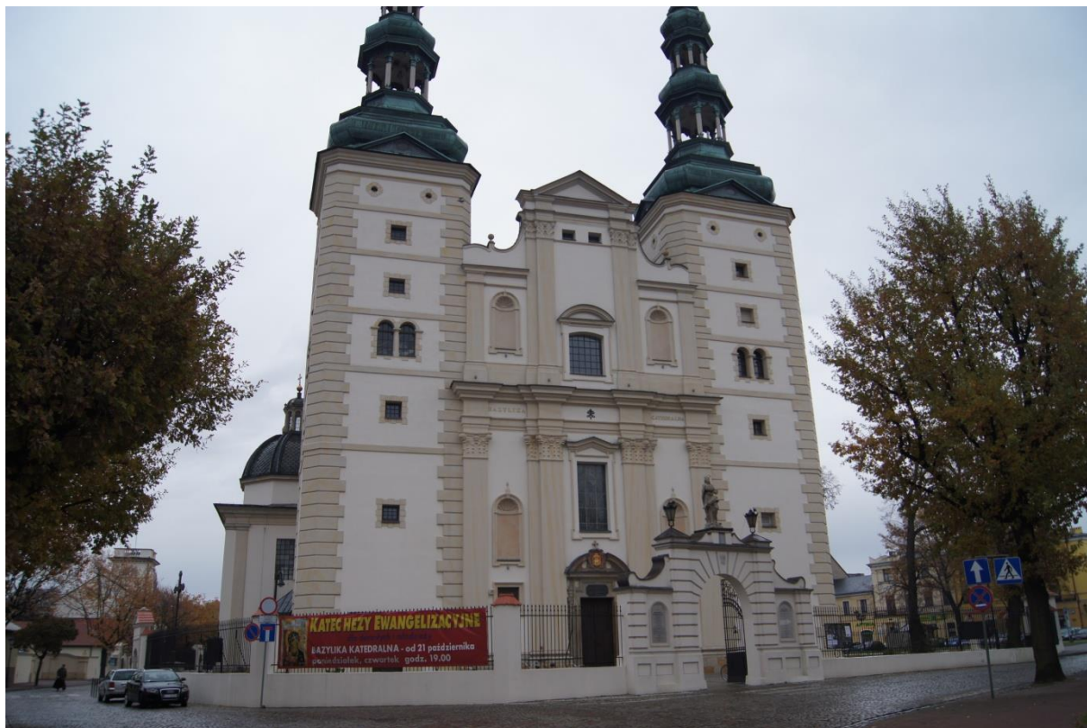
Kolegiata po przeprowadzonym procesie rewaloryzacji
