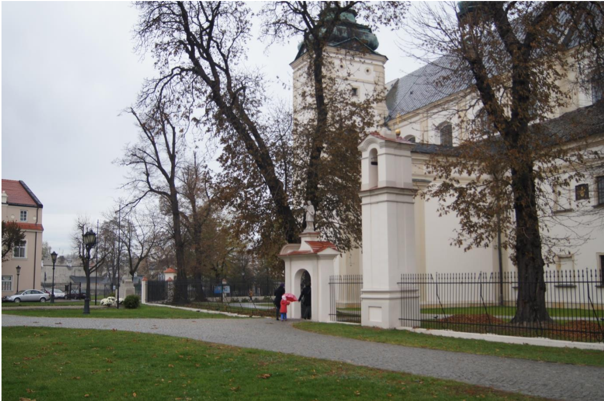
Wyremontowane ogrodzenie otaczające Kolegiatę
