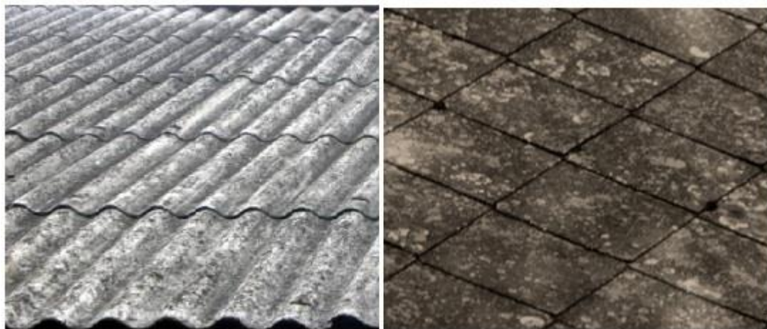
Rys. nr 1. Wyroby azbestowo – cementowe: po lewej płyty faliste, po prawej płyty płaskie, typ „Karo”
