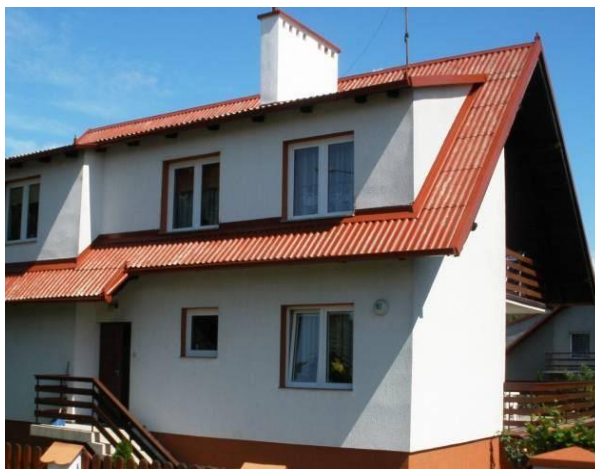
Rys. 5. Przykład zabezpieczenia wykonanego powłoką malarską.
