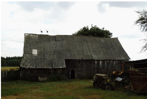
Rys. 1. Wyroby azbestowo–cementowe: po lewej płyty faliste, po prawej płyty płaskie, typ „Karo” (źródło: materiały własne)
