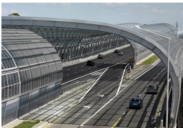
Rysunek 12. Ekranu akustyczne w formie tuneli oraz półtuneli na Trasie Toruńskiej w Warszawie
