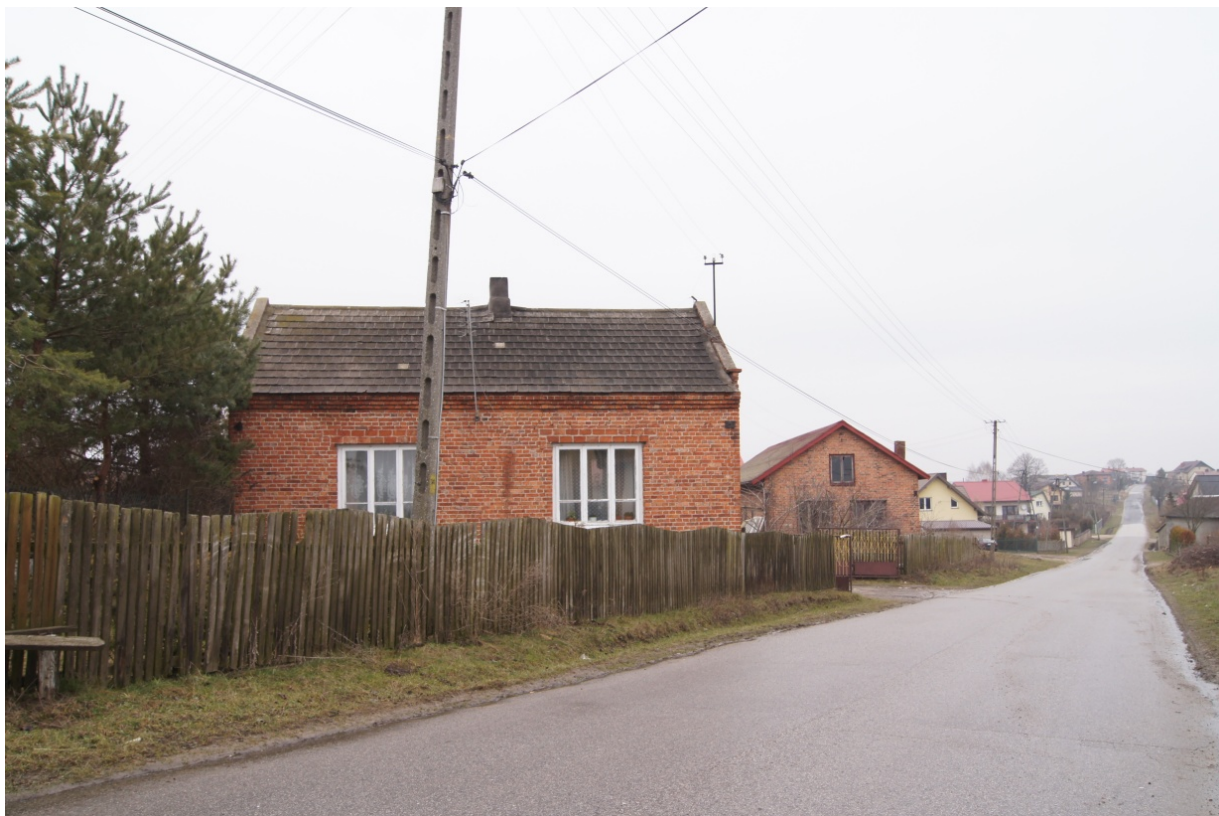
Barkowice układ ruralistyczny wymagający rewitalizacji
