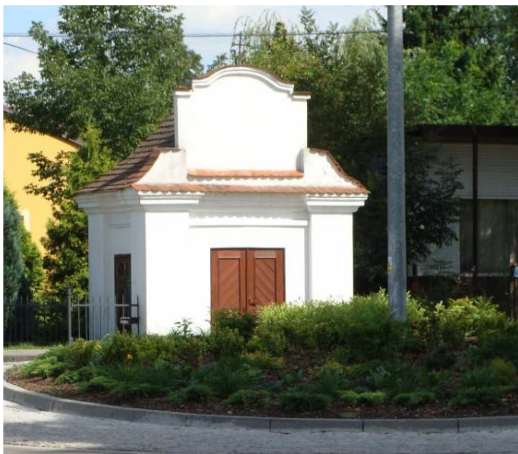
Kapliczka w Sulejowie-Podklasztorzu po remoncie
