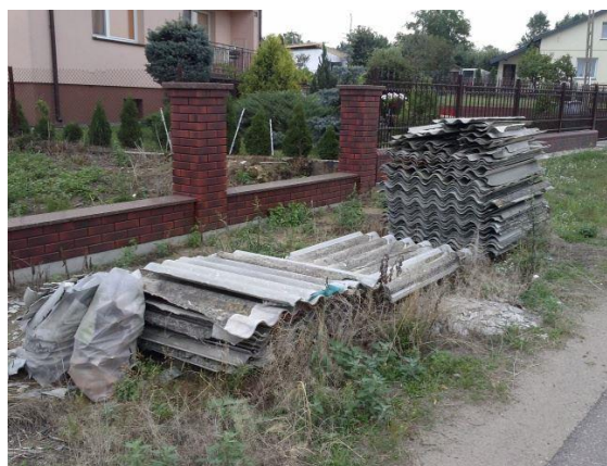
Rys. 3. Płyty azbestowe faliste złożone na paletach i w workach (źródło: materiały własne)
