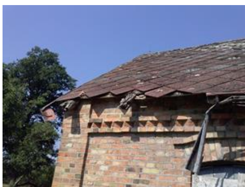
Rys. 2. Wyroby azbestowo-cementowe: po lewej płyty faliste, po prawej płyty płaskie, typ „Karo” (źródło: materiały własne)
