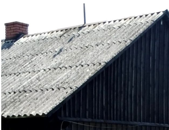
Rysunek 1. Wyroby azbestowo – cementowe: po lewej płyty faliste, po prawej płyty płaskie (źródło: materiały własne)
