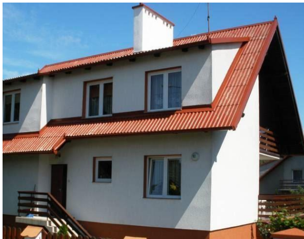
Rys. 5. Przykład zabezpieczenia wykonanego powłoką malarską (źródło: materiały własne)
