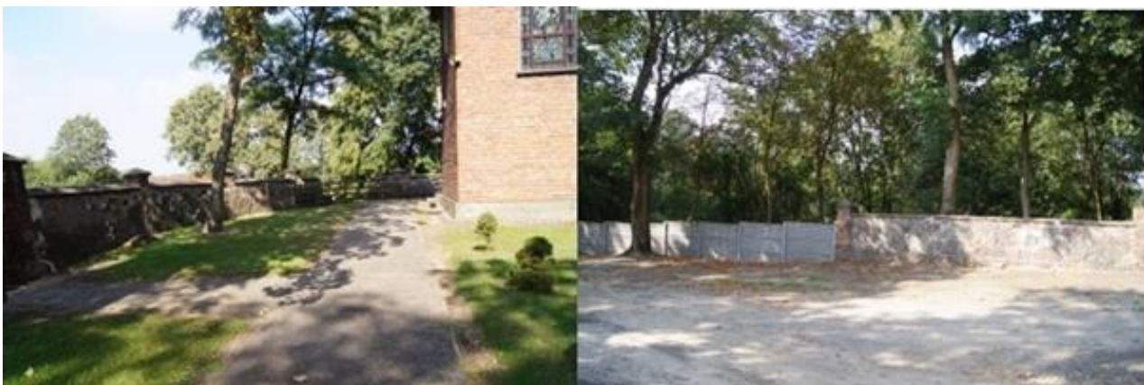
Ogrodzenie kościoła w Starych Skoszewach wymagające prac rewaloryzacyjnych i fragment nowego ogrodzenia z prefabrykatów betonowych kolidujących z zabytkową strukturą
