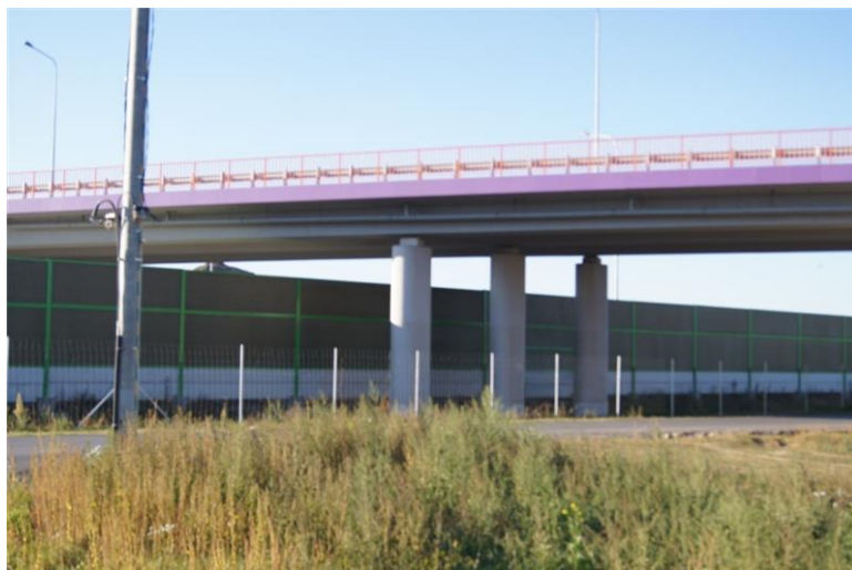
Degradacja krajobrazu spowodowana budową autostrady
