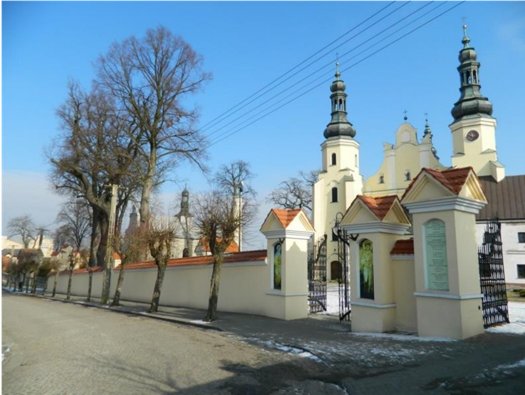
Warta, klasztor oo. Bernardynów – mur klasztorny
