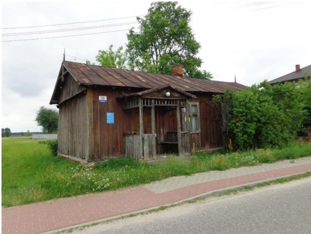
6) Dom drewniany nr 34 (wez) - do wykreślenia (przebudowany)
