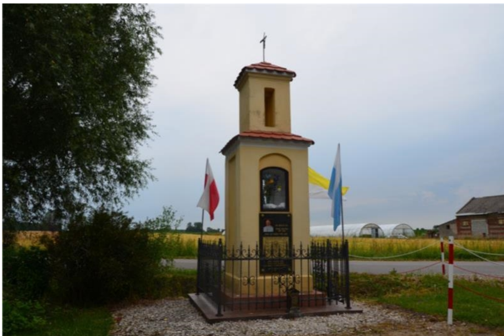
2) Budynek mieszkalny nr 28 (gez) - nie ujmować w gez(zły stan)
