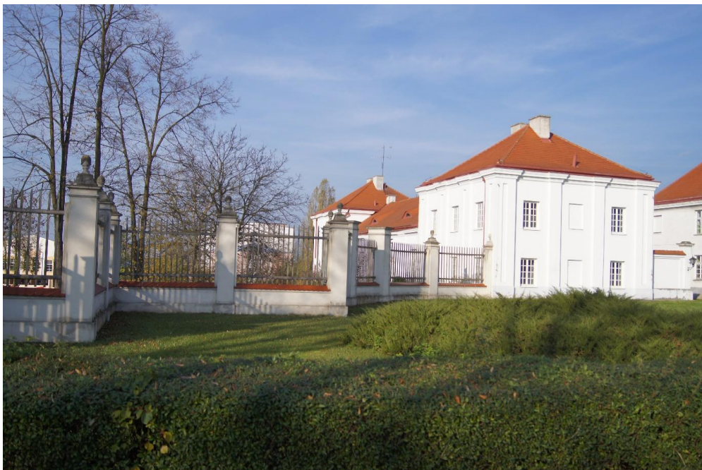
Elewacja północno-wschodnia pałacu Biskupów Kujawskich w Wolborzu
