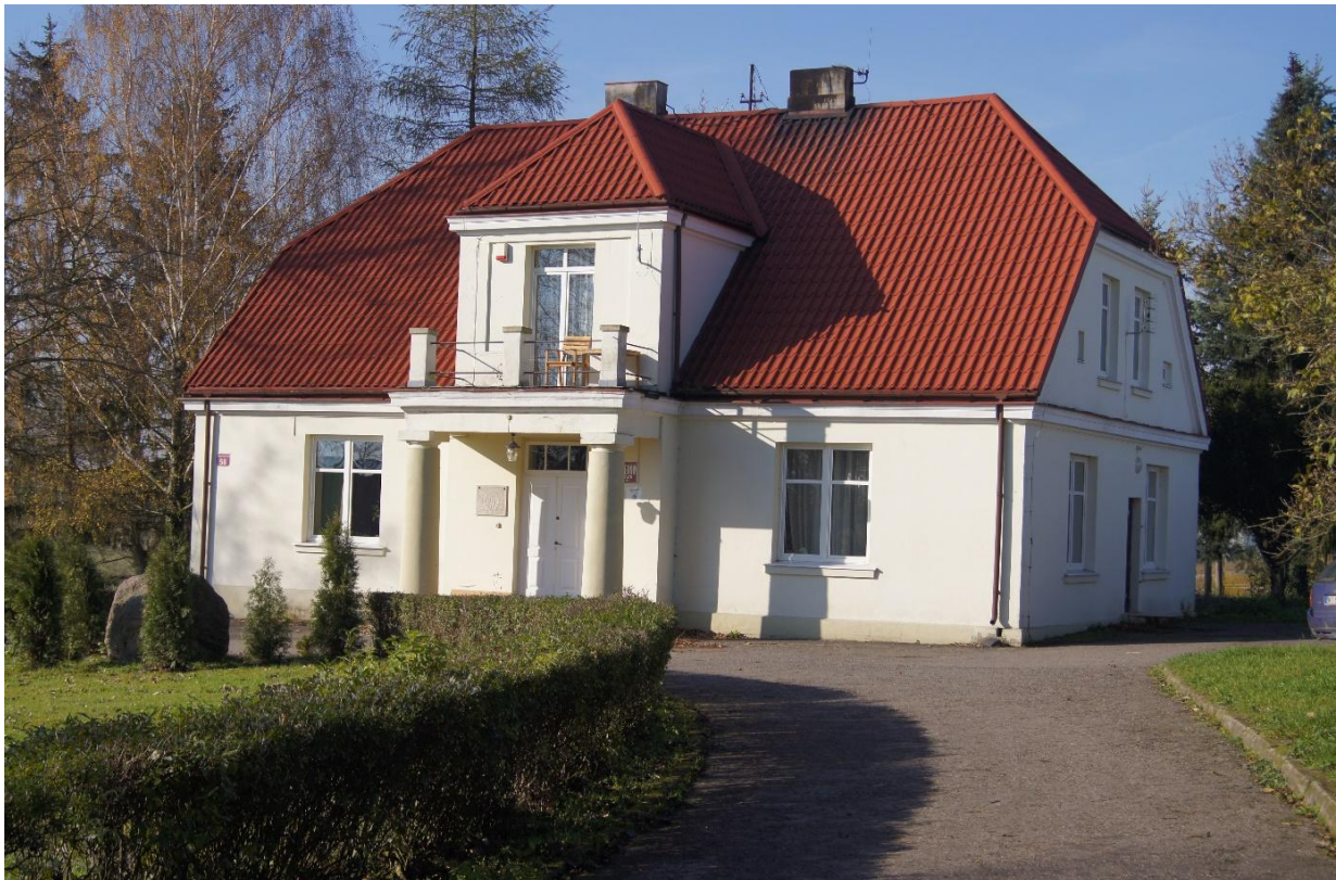
Budynek biurowy w Bogusławicach
