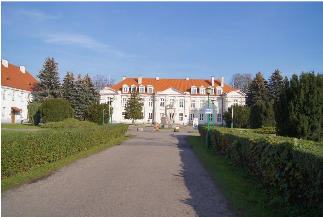
Budynek frontowy Pałacu Biskupów Kujawskich w Wolborzu
