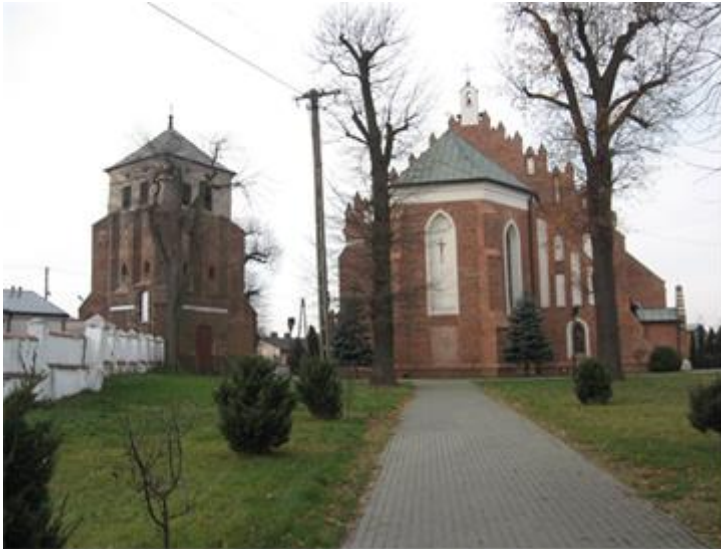
Rys. 2 Kościół parafialny pw. Wniebowzięcia NPM i św. Jakuba Apostoła – widok od strony wschodniej.
