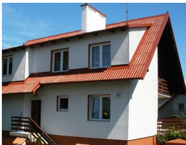
Rys. 5. Przykład zabezpieczenia wykonanego powłoką malarską.
