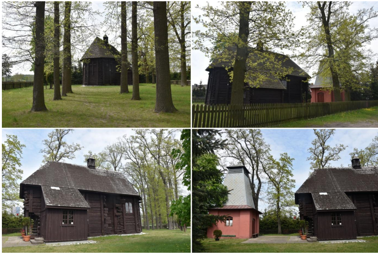
Fot. 1. Budzynek. Kościół p.w. Ścięcia św. Jana Chrzciciela (fot. autor opracowania).
