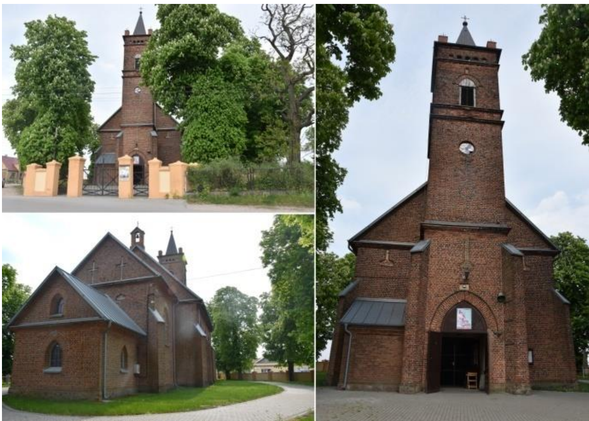
Fot. 2. Strzegocin. Kościół p.w. ŚŚ. Bartłomieja i Wojciecha (fot. autor opracowania).
