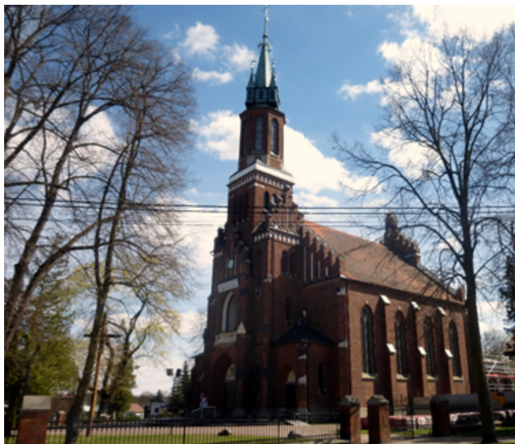
Charłupia Mała - kościół pw. Narodzenia NMP(fot. M. Urbański)
