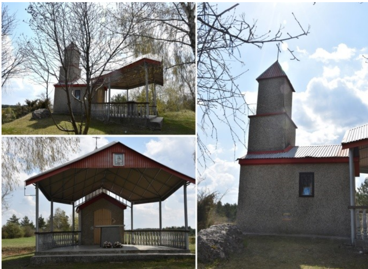
Fot. 2. Raciszyn, kaplica p.w. Serca Jezusowego (fot. autor opracowania).
