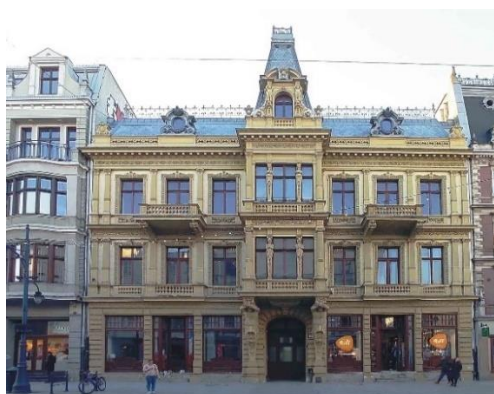
Łódź. Kamienica czynszowa wielkomiejska stylowa
