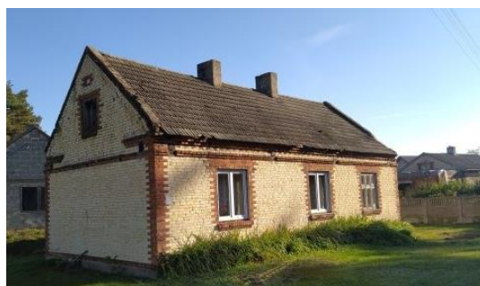
Człopy. Dom z kamienia wapiennego
