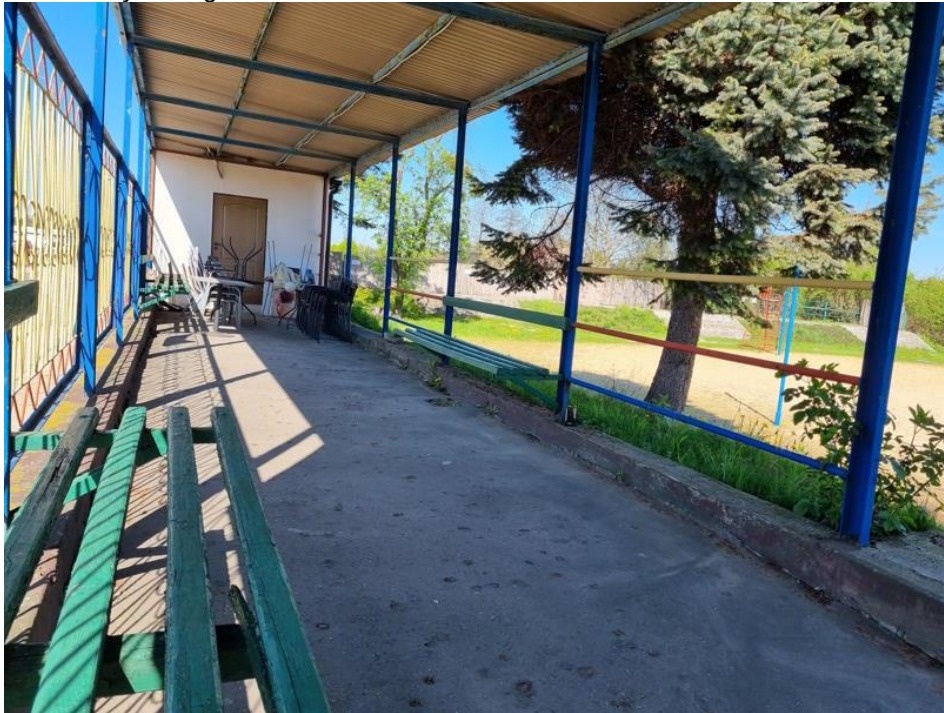
Fotografia 34. Obiekty starego basenu w Wieluniu
