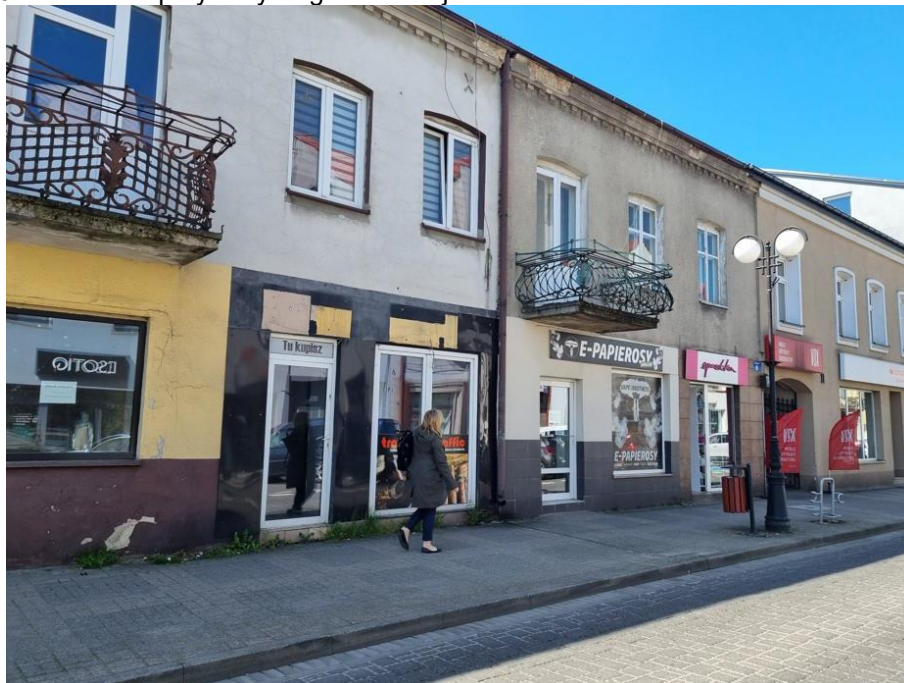
Fotografia 36. Kamienice przy ulicy Augustiańskiej
