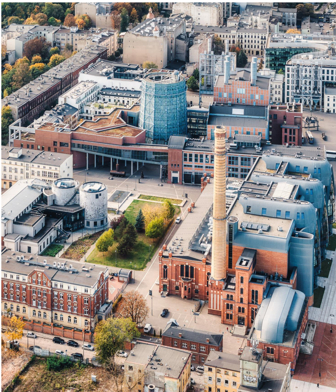
Elektrociepłownia 1 - EC1, ul. Targowa 1/3
