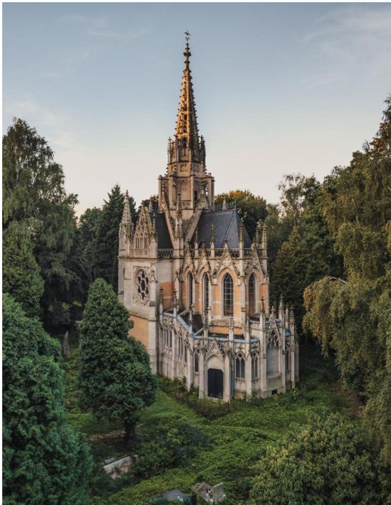
Kaplica Scheiblera na Starym Cmentarzu, ul. Ogrodowa 43
