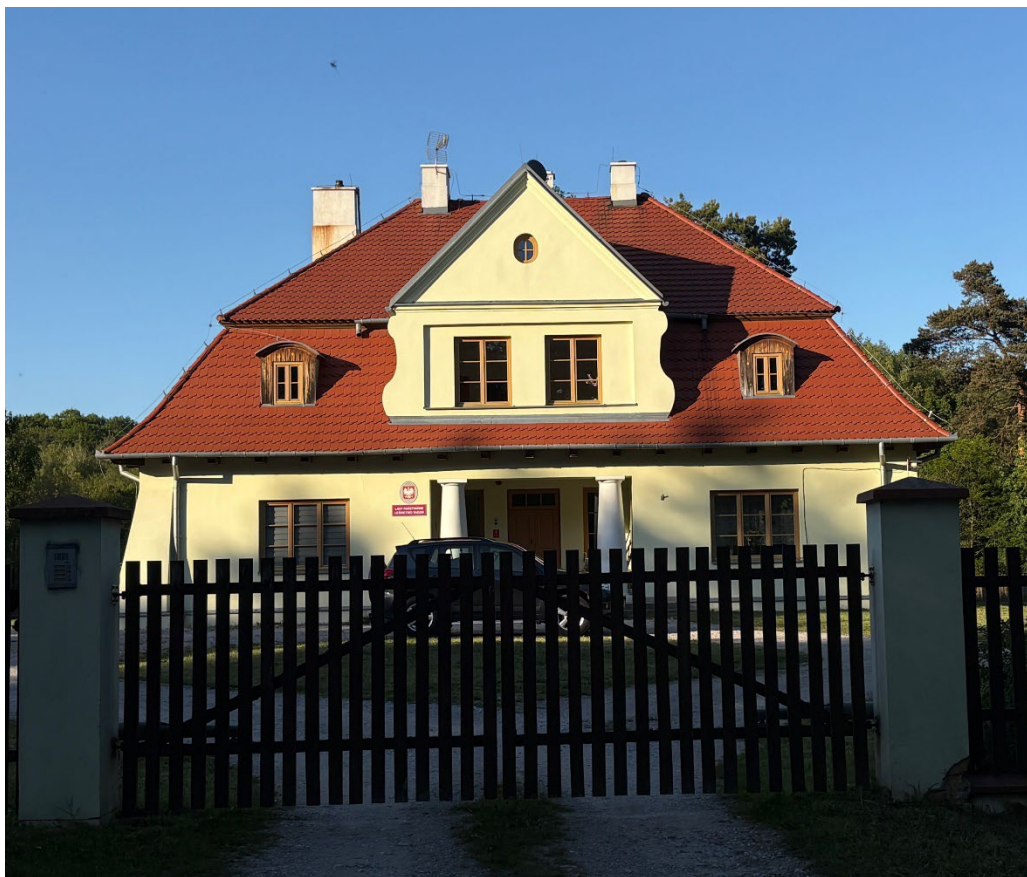
Zdjęcie. Dom nadleśniczego, stan obecny, zdjęcie własne.
