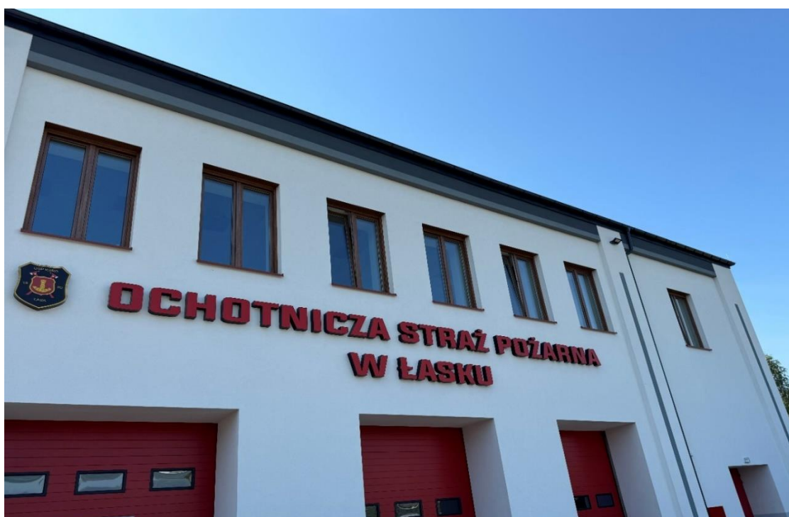
– Termomodernizacja budynku OSP w Łasku –
