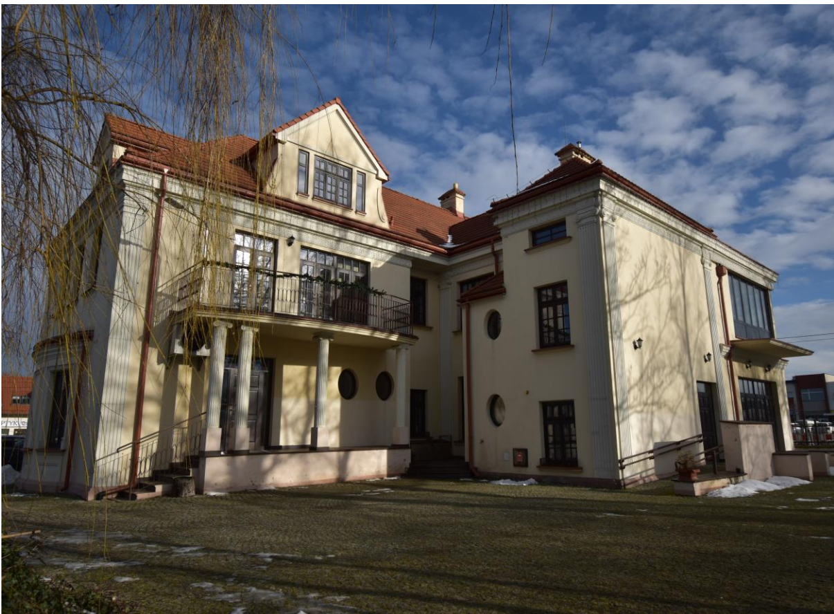
il. 3. Willa R. Hoffmana, ul. Jana Pawła II nr 1, murowana, pocz. XX w. Siedziba GDKzB.(ewidencja zabytków)
